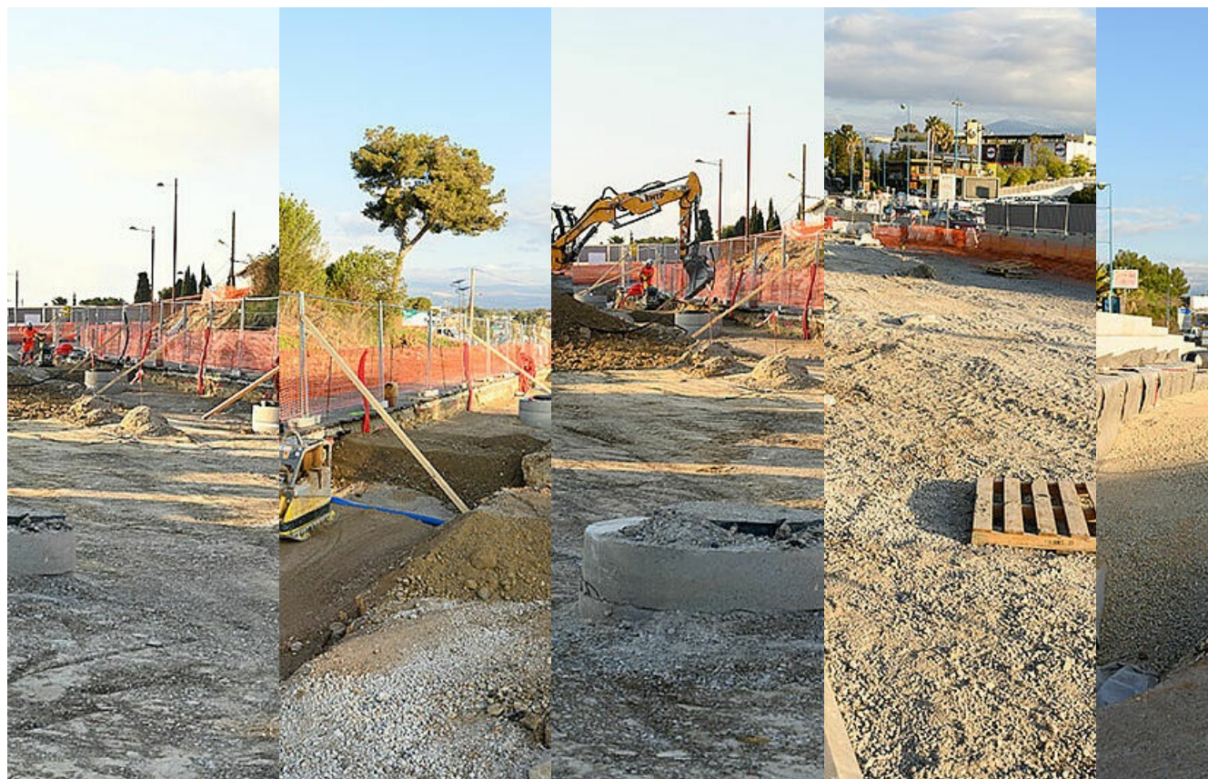
Photos en date du 07 avril 2023
