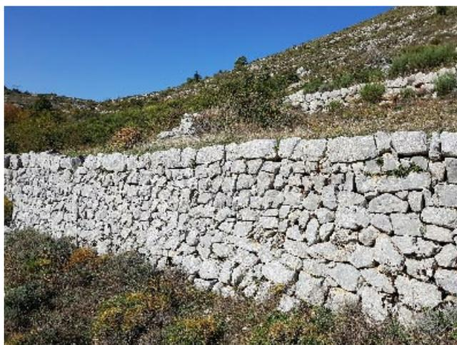
**Ces murs en pierre sèche, c'est-à-dire sans liant pour assembler les pierres** ont été construites au fil des siècles pour augmenter les surfaces agricoles utiles et conserver un maximum de terre arable en limitant les effets de l'érosion.
