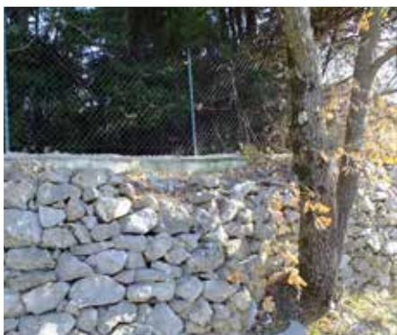
Insertion de clôture fortement visible du fait du muret en parpaings surplombant directement le mur en pierre sèche. **À éviter !**
