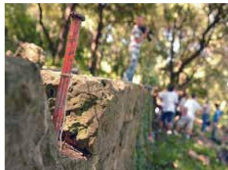
Cordeau fixé dans le mur grâce à une pointerolle (restauration de la partie haute du mur).
