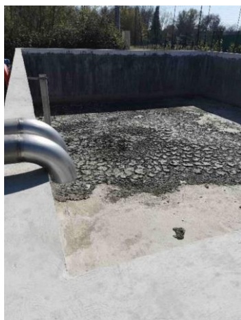
Création d'un bassin d'orage STEP de Châteauneuf-Grasse
