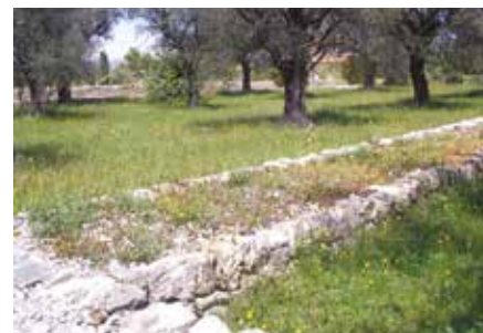
Bonne implantation des arbres sur une restanque.
