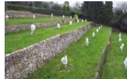
Des murs hauts et des terrasses étroites pour aménager une pente forte, Plascassier, Grasse.
