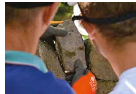
Choisir la pierre qui permet de réduire au minimum les vides.
