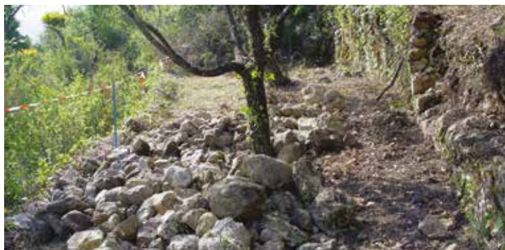
Devant le mur, un espace laissé libre permet de réaliser le chantier sans être gêné.
