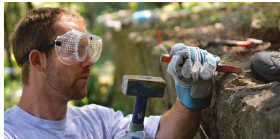
Taille de pierres, équipement de sécurité.
