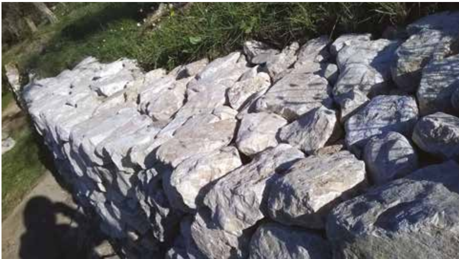
Vue du haut du mur : pierres de couronnement.
