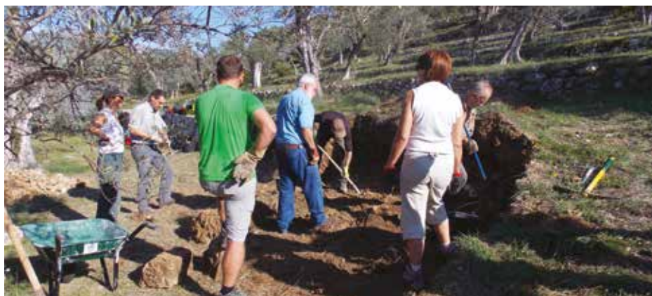
Préparation des fondations, chantier d'initiation, Opio.
