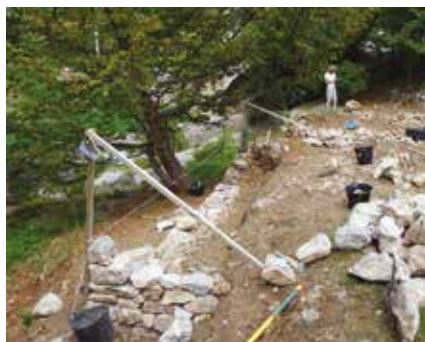
Murs se terminant par un mur en retour vers le haut du versant, Tourrettes-sur-Loup.
