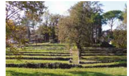
Une pente faible : un rang de pierre suffit, Grasse.
