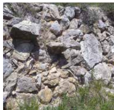
Escalier « volant », Sigale.
