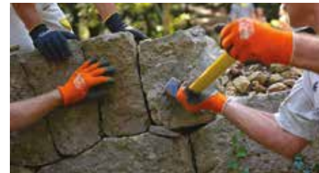
La massette utilisée pour pousser une pierre.
