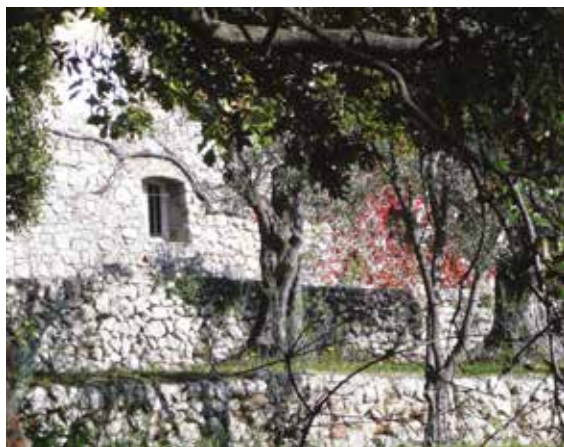
Le soubassement de cette maison s'insère harmonieusement dans les restanques.
