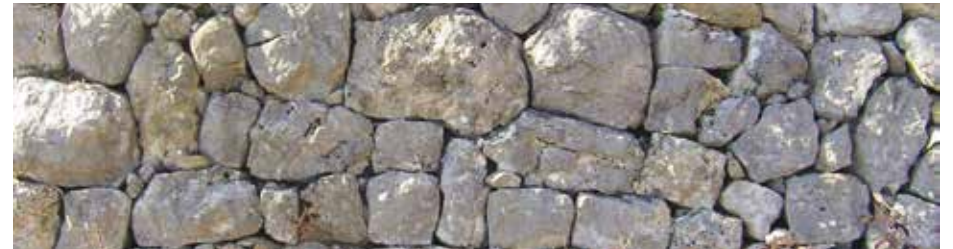
Mur en pierre sèche, Gréolières.
