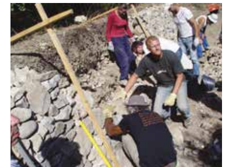
Guitare et cordeau placé après démontage en escalier de la partie du mur à restaurer.
