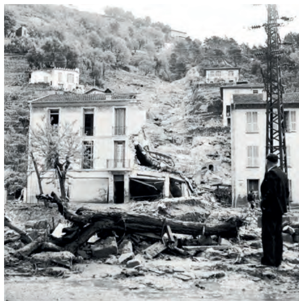
Maison saccagée après des pluies torrentielles à Menton, 1952, photographie Mario Marquet
