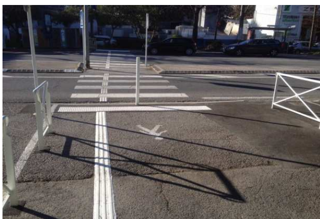
Réalisation de bandes de guidage de l'arrêt de bus à la loge du gardien
