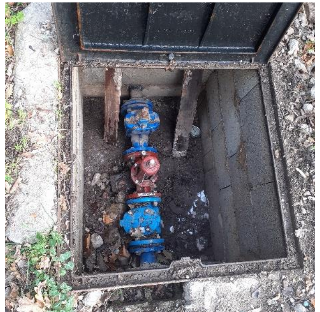
Quartier St Pons : mise en place d'un bypass afin de réguler au mieux le quartier du Thoronet.
