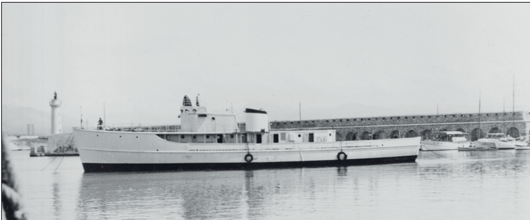
La Calypso dans le port Vauban, pendant les travaux en 1951.
