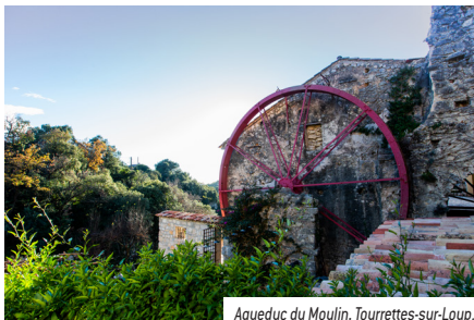
Aqueduc du Moulin, Tourrettes-sur-Loup.
