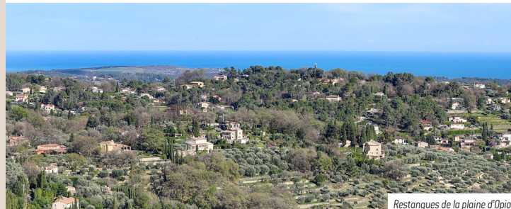
Restanques de la plaine d'Opio.
