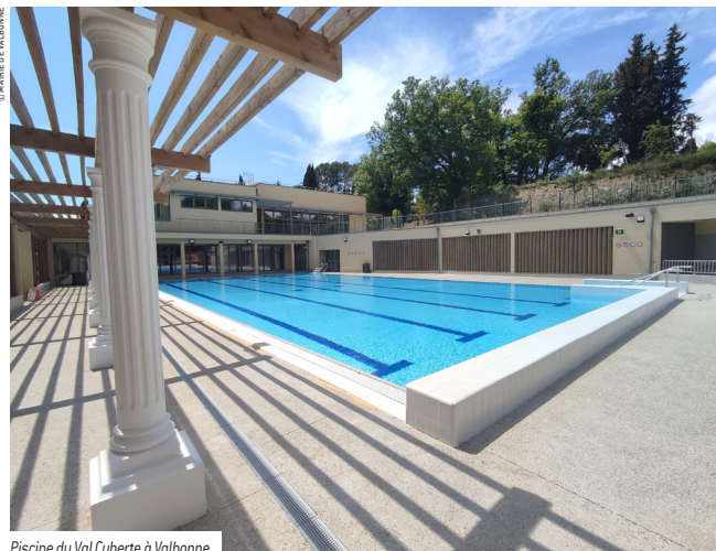
Piscine du Val de Cuberte à Valbonne.
