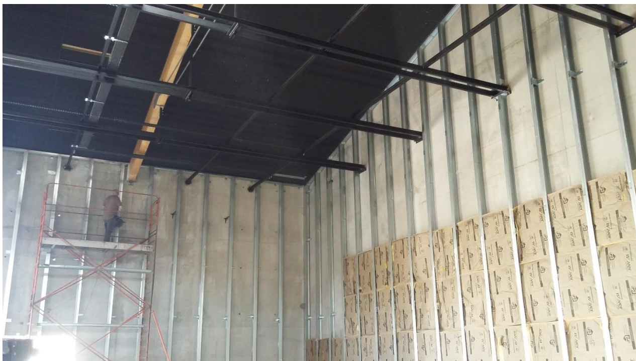
Doublage acoustique et thermique intérieur dans la grande salle, Serrurerie scénique
